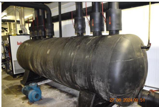
Termički izoliran spremnik rashladnog medija
