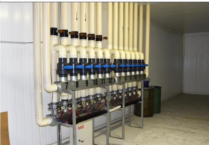
Cijevni razvod u rashladne komore sa ventilima
